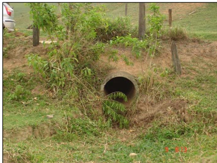
**Figura 3.1-9: Dreno construído para escoamento das águas da lagoa.**
